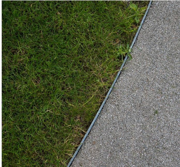
Стык газона и гравийной парковой дорожки производить металлической бордюрной лентой
