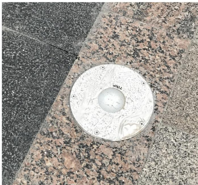
Бесшовная врезка грунтового светильника в тротуарную плитку
