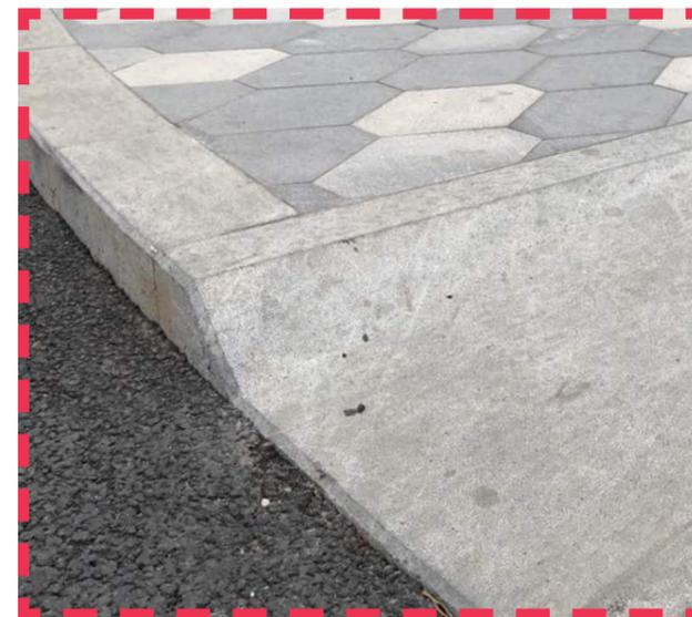
стык бетонной дорожки и асфальта (парковки)
